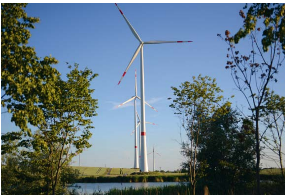
Statt 6 Windkraftanlagen mit 3,3 Megawatt Nennleistung werden im Windpark Grünow nun 4 Windkraftanlagen mit einer Gesamtleistung von 13,2 Megawatt betrieben.
